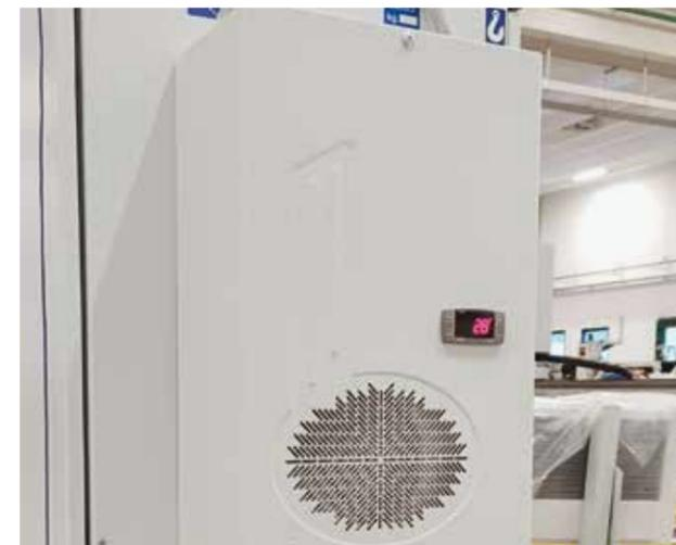
Unidad de aire acondicionado para controlar la temperatura y la humedad del armario eléctrico.
