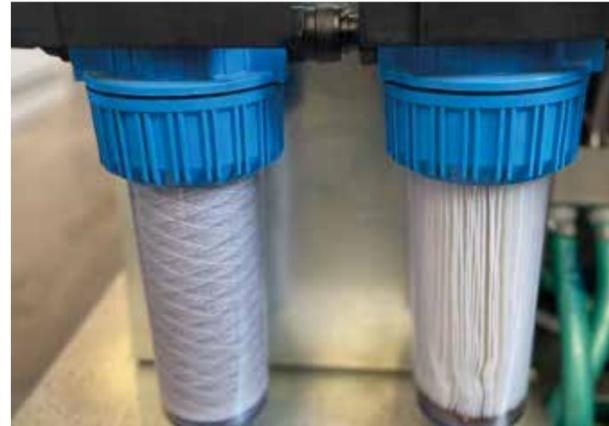
Doppelte Propylen-Filterpatrone mit verdrehtem und gefaltetem Draht zum Filtern von Sedimenten aus dem eingehenden Leitungswasser von 10 Mikron bzw. 1 Mikron. Sensoren überwachen den Verstopfungsstatus und melden die Verschmutzung mit Warnhinweisen auf dem Bedienfeld.
