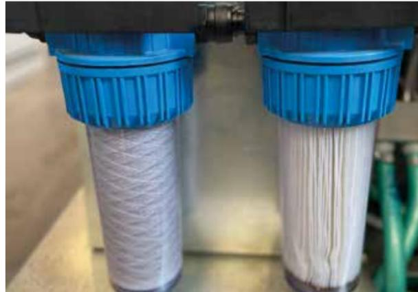
Doppia cartuccia filtrante in propilene a filo ritorto e plissettato per la filtrazione dei sedimenti dall'acqua di rete in ingresso rispettivamente da 10 micron e 1 micron. Grazie alla presenza di sensori viene monitorato lo stato di intasamento e segnalata la sostituzione con warning sul pannello di controllo.
