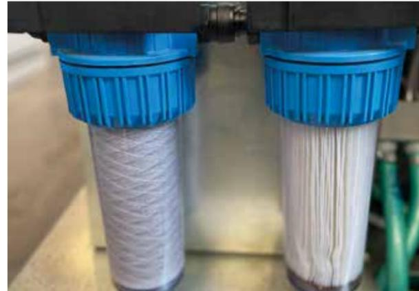
Два пропиленовых фильтрующих картриджа из крученой нити и гофрированный для фильтрации осадка из поступающей сетевой воды размером 10 микрон и 1 микрон соответственно. Благодаря наличию датчиков осуществляется контроль за состоянием засорения и подается сигнал на панели управления о необходимости замены.
