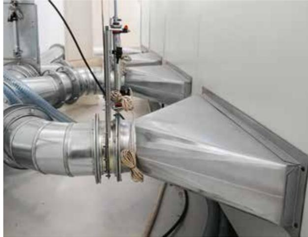
Sistema di aspirazione polveri per un efficace ricambio aria e abbattimento polveri all'interno dell'area di lavoro
